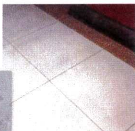
細孔に汚れが入り込んだ セラミックタイル
